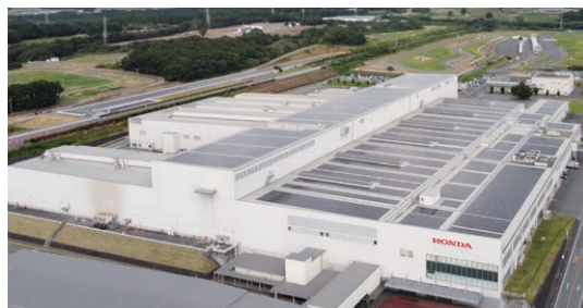
熊本製作所 (3.8MW)
