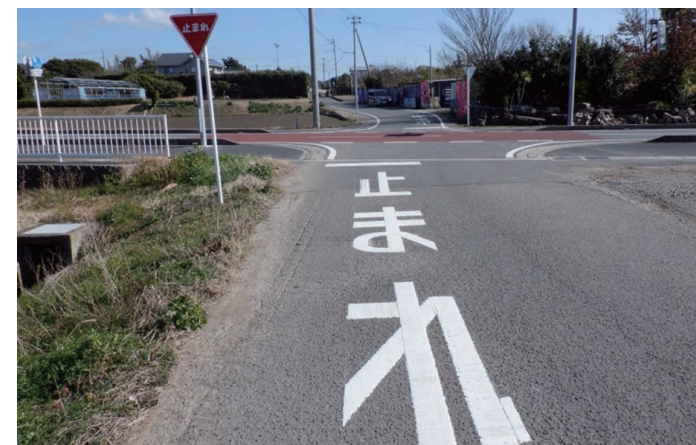
改善後：道路標示（止まれ）の補修、交差点内カラー舗装を実施
