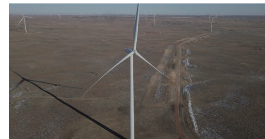
ボイリング・スプリングス風力発電所 (120MW)
