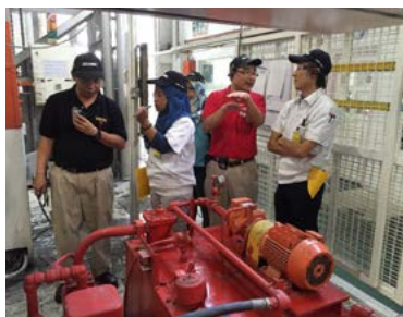
お取引先現場での取り組み確認
