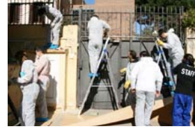
養護施設を改修するアソシエイト
