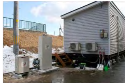
トレーラーハウスに電力と温水を供給する ガスエンジンコージェネレーションユニット「MCHP1.0K2」。 トレーラーハウスでは地元特産品の販売や多目的スペースとして、一人暮らしのお年寄りの見守り支援などがおこなわれています。2年半の期間限定、運営は地元のNPOが担当しています。
