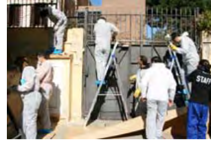
養護施設を改修するアソシエイト
