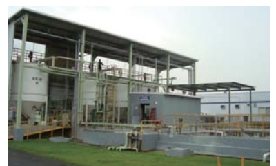
水質改善された水は、敷地内の庭や緑地帯の灌漑に再利用
