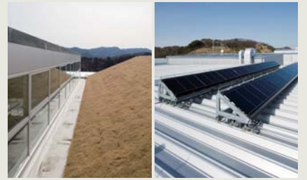
屋上緑化と太陽電池
