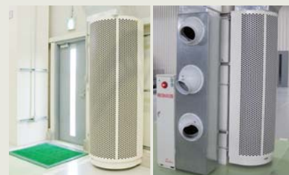
作業域に合わせ高さ効果的に空調する吹き出し口
