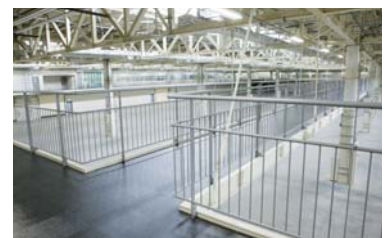
スカイウォークにより、生産と人の動線を分離。工場内の安全性向上と快適に移動できる環境を実現しています。
