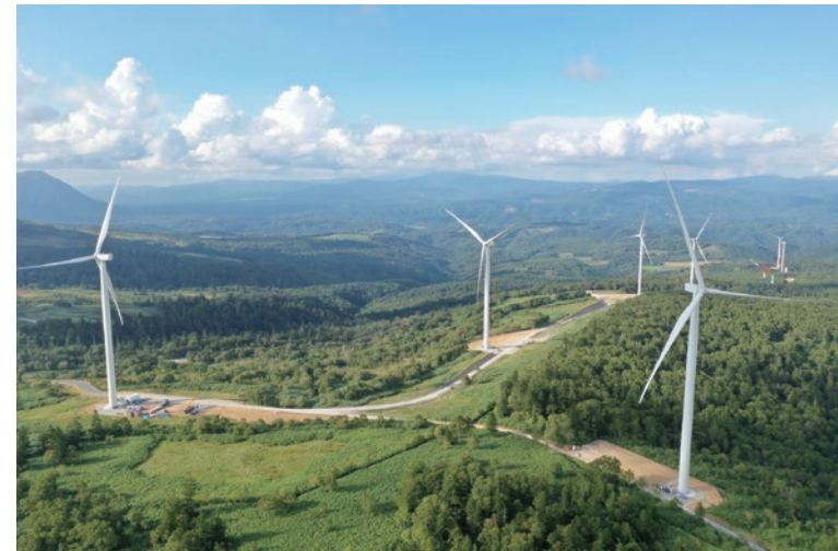
留寿都風力発電所 (留寿都ウインド合同会社)
