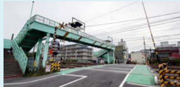
踏切の横には歩行者のための跨線橋(歩道橋)が設けられている
