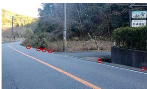
生徒たちの提案で実現した路肩の溝の注意を促す反射視線誘導板(赤丸部分)
