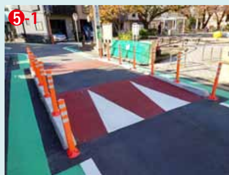
ハンプは台形状で、通過する際に不快感を与えることでドライバーに減速を促す
