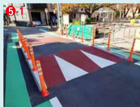
5-1 ハンプは台形状で、通過する際に不快感を与えることでドライバーに減速を促す
