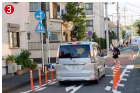
車両の通行部分の幅員を狭く絞る狭さくを通過するクルマ。横断歩道を渡ろうとする歩行者がいたため一時停止した
