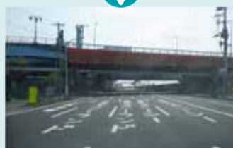
行き先地の路面標示設置
