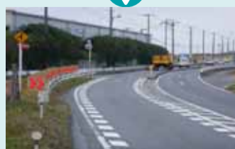
減速ドット表示の設置、中央分離帯デリネータ(視線誘導標)設置
