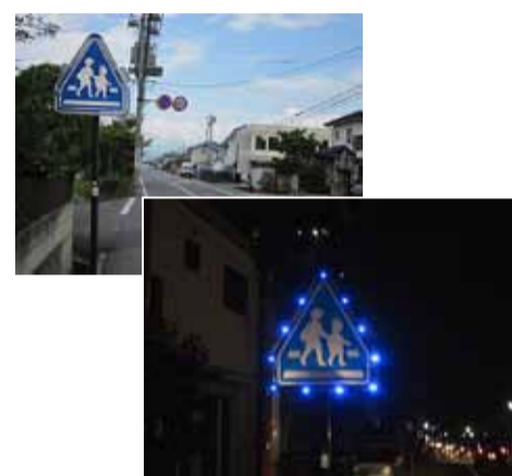
長野県が独自に開発した外周発光装置付き横断歩道標識
