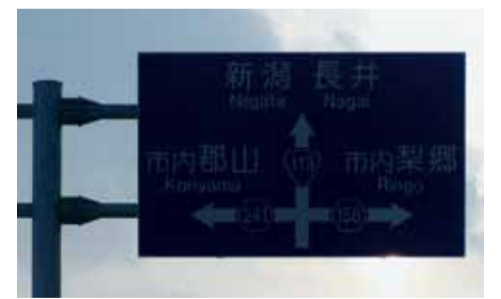
電気を使わず、手動で最大4つの表示に切り替えられる四可変標識
