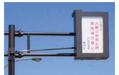
電気を使わず、手動で最大4つの表示に切り替えられる四可変標識
