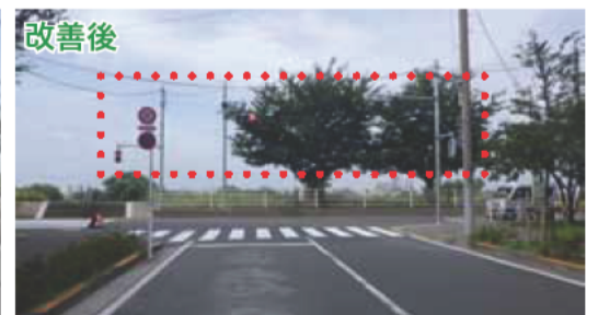
「SAFETY MAP」の急ブレーキ多発地点情報をもとに現場を確認し対策した実施例。改善前にはなかった信号機を設置
