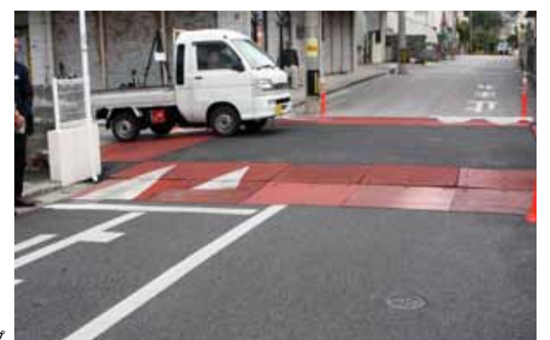
交差点ハンプは交差点内部全体を盛り上げるハンプ
