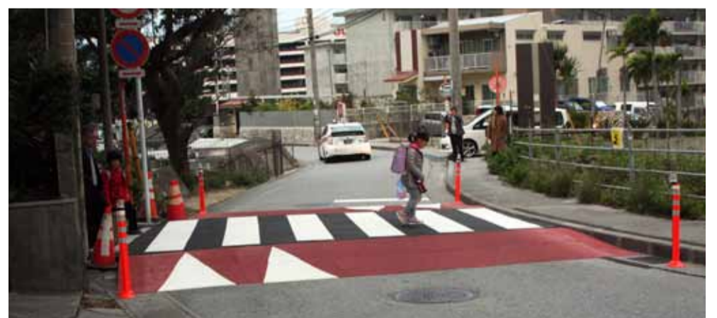
スムーズ横断歩道はハンプ（道路の一部を盛り上げたもの）の一種。ハンプ中央の平坦部に横断歩道が描かれている
