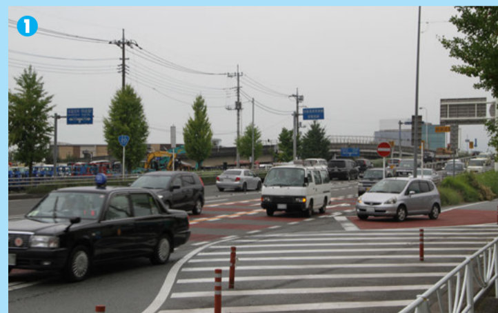
Aから左折専用レーンに進入する車両と側道からの合流待ちの車両が接近する様子。発進タイミングを誤れば事故につながりかねない
