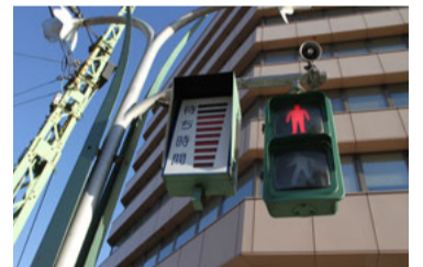
C に設置された歩行者用信号機には待ち時間表示が設けられているほか、音声アナウンスで「間もなく信号が変わります。横断はやめましょう」「歩行者信号は青になりました。右、左を見て渡りましょう」と歩行者・自転車利用者の注意喚起を行っていた
