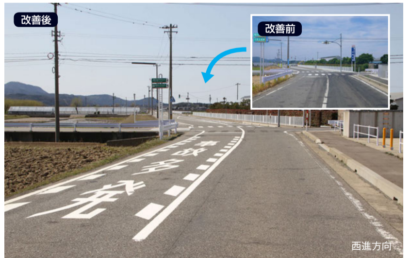
SAFETY MAP上には、交通安全対策がなされた事例などを「SAFETY ACTION」として公開しており、急ブレーキ多発地点や、比較的スピードの出やすい道路などに対して、路面表示の追加を実施するなど、施行前後の写真とともに紹介。福井県坂井市の石塚交差点の実例も掲載されている
