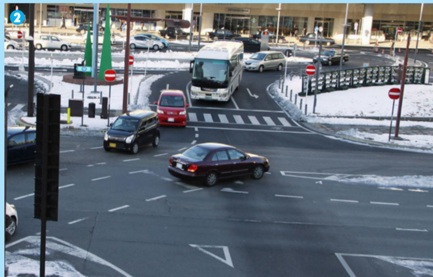
3 交差点内が狭いため、右折レーンの停止線は直進車両近くに引かれている
