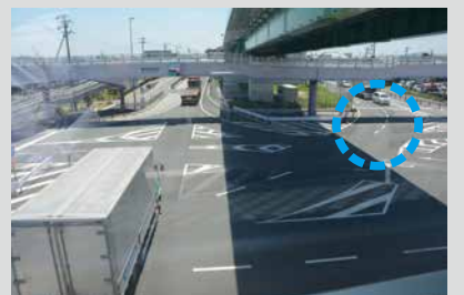
従来は右折車線の停止線は直進車線の直前に設置されていたが、後方に移動された
