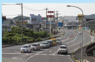
直進が優先となるように車線を整理(改良前、直進車は左折レーンから直進レーンへの車線変更が必要だった)
