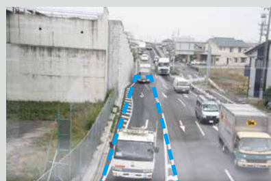
1車線のみだった右折レーンは2車線となり、渋滞状況が改善
