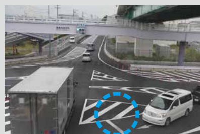
従来は右折車線の停止線は直進車線の直前に設置されていたが、後方に移動された
