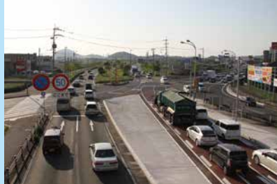
右折レーンを対向車線側に寄せ視認性を改善するとともに矢印式信号により直進と右折の車両を分離
