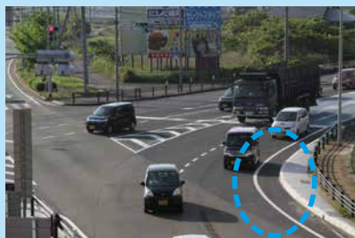
従来は車両の速度が高かったが、交差点の角をせり出すことで速度を抑制
