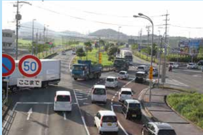
右折レーンを対向車線側に寄せ視認性を改善するとともに矢印式信号により直進と右折の車両を分離
