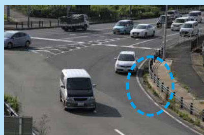
従来は車両の速度が高かったが、交差点の角をせり出すことで速度を抑制
