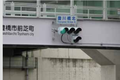
矢印式信号を導入して直進と右折の車両を分離
