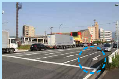
直進と左折が併用だった歩道側の車線を左折専用にして渋滞を緩和
