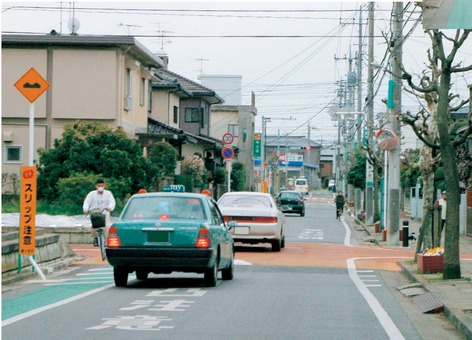
鎌ヶ谷市の東初富地区内では、交通事故やヒヤリ体験の多い交差点に、交差点の路面を盛り上げたハンプが設置された
