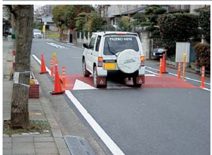
平成15年11月26日から12月2日まで東初富地区内の道路にクルマの走行速度を抑制するための仮設のハンプや狭さくを設置し、社会実験が行われた
