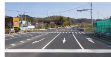
改善後: 停止線を倍幅化し、横断歩道を補修
