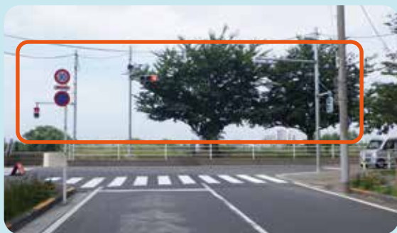
改善後：信号機を設置
