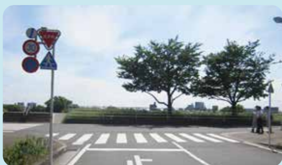
改善前：急ブレーキ多発地点に信号機なし
