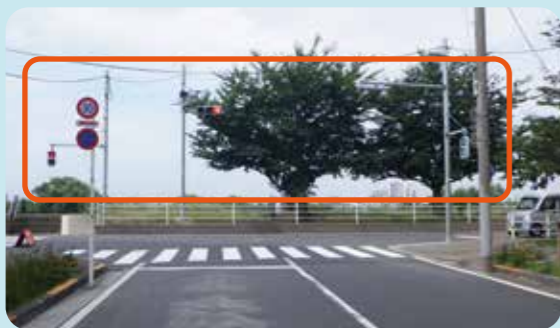
改善後：信号機を設置
