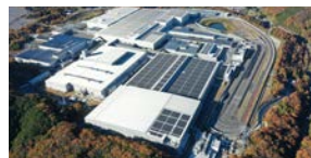
埼玉製作所 完成車工場 カーボンニュートラル工場化
