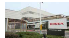
パワートレインユニット製造部
