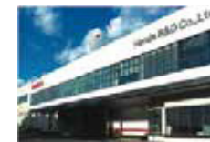
先進技術研究所 先進パワーユニット・エネルギー研究所 デザインセンター／統括機能センター
