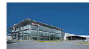
埼玉製作所 エンジン工場
