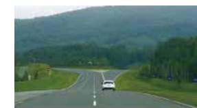
鷹栖ブルービンググラウンド
