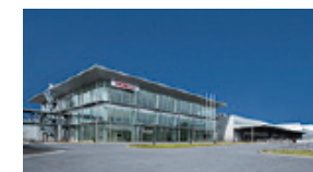
埼玉製作所 エンジン工場
