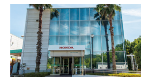
ライフクリエーション事業本部 細江船外機工場
