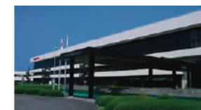
四輪R&Dセンター (栃木/栃木ブルーピンググラウンド)
