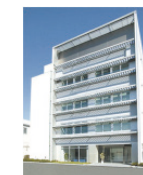
航空機エンジンR&Dセンター
