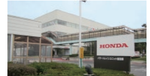
パワートレインユニット製造部
