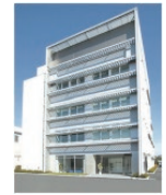
航空機エンジンR&Dセンター
