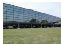
断熱効果の高いペアガラスをはじめ、さまざまな環境配慮を実施した新建屋(ホンダ太陽(株))
