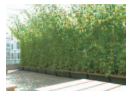
グリーンカーテンを設置し、空調による電力消費量を低減(学校法人 ホンダ学園)
