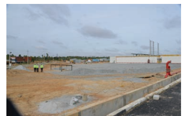
雨水貯留システムにより、年間約2万トンの地下水の利用を節約
