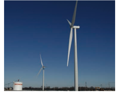
工場使用電力の約10%をまかなう風力発電設備
