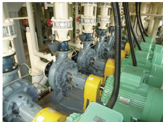
冷水ポンプ更新
