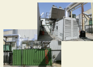
新しく導入された天然ガス発電機とコージェネシステム
