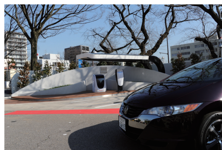
埼玉県庁前に設置されたソーラー水素ステーションと、FCXクラリティ
