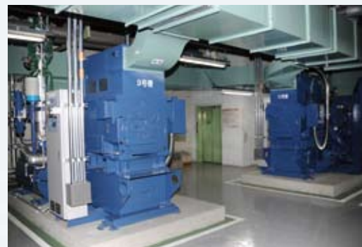
高効率で大容量のIGVターボコンプレッサー
