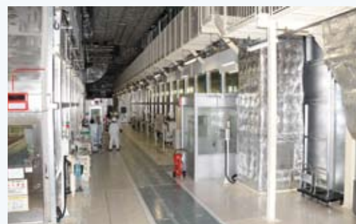
2009年5月に完成した新建屋内
