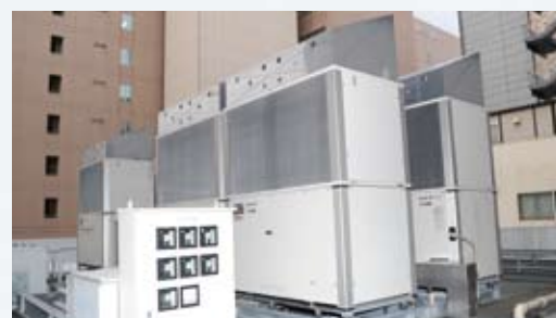
2階の屋上にGHPを7台設置
