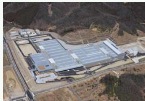
工場の北側にはゲンジボタルが生息する湿地帯がある
