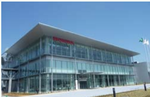
透明ガラスで内部が見える開放的な小川工場。 路面舗装も遮熱や混合材で環境配慮
