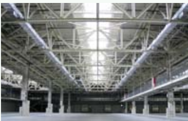
工場では屋根のトップライトから採光。 照明は高効率照明で照度が高いところは間引き
