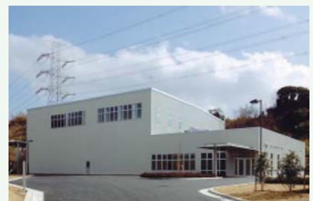
かずさ分室全景 (敷地面積：5,000m 2 、延床面積：1,249m 2 )
