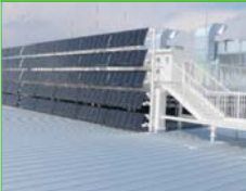
地下水熱活用型 給気冷却システム
