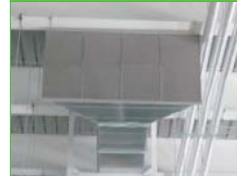
事務所太陽光活用 明かりとり
