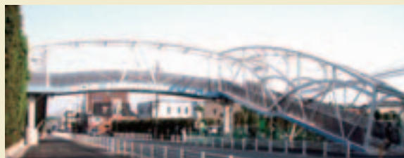
2007年5月に開通した歩道橋
