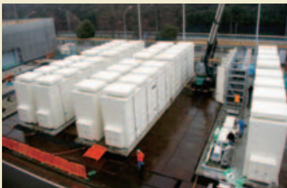
四輪開発センター（栃木）に建設中のNAS電池システム
