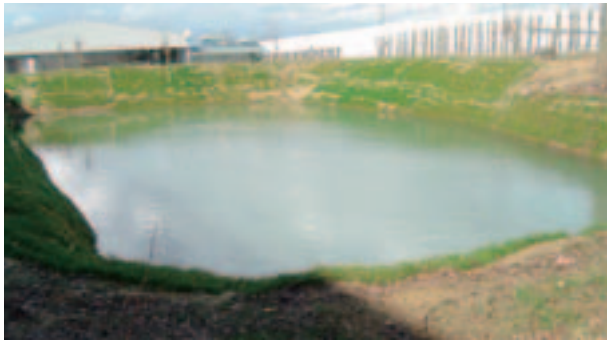
雨水の貯水池
