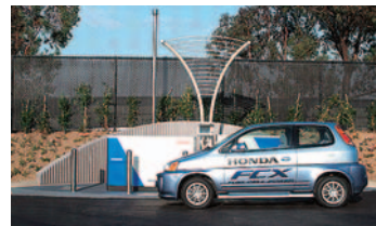
ホーム・エネルギー・ステーションの外観とFCX
