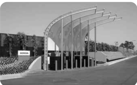
水素製造・供給ステーション概観
