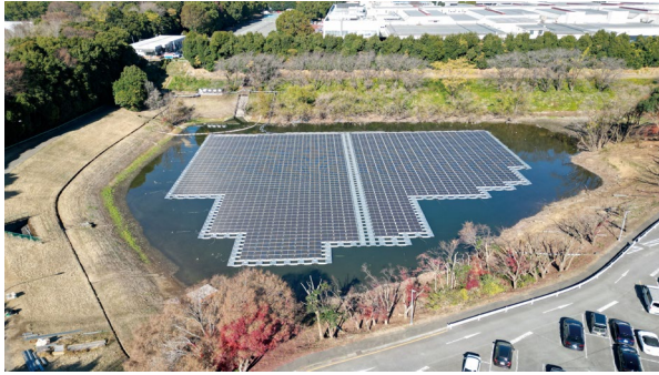
熊本製作所敷地内の調整池に設置された太陽光パネル
